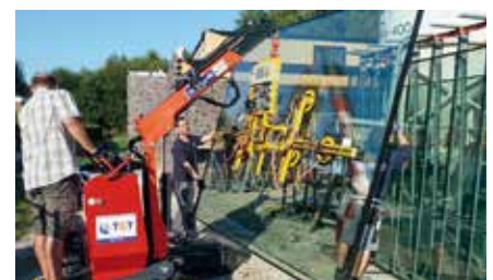
Schritt 3: Stellen Sie das Teleskopfahrwerk für einen sicheren Stand in der Breite je nach Scheibenformat und -gewicht ein.
