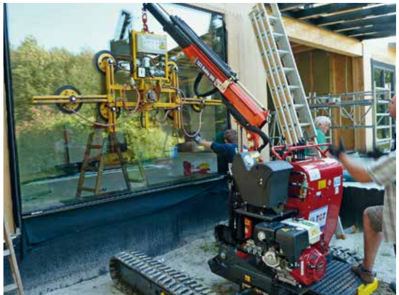
Ohne Standsicherheitsverlust schwenkt der Kranearm von TGT Robby 900 Universal um 20 Grad nach links und rechts. Die Steuerung variiert der Nutzer zwischen schnell (Profis) und langsam (Anfänger).
