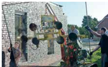
Schritt 4: Fahren Sie mit der angehängten Scheibe zum Fensterrahmen. Mindestens eine Person führt die Verglasung per Hand.
