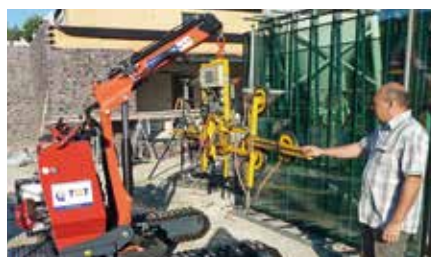
Schritt 2: Markieren Sie den Mittelpunkt der Scheibe und saugen Sie die Verglasung mit dem Kranearm exakt an dieser Stelle an.
