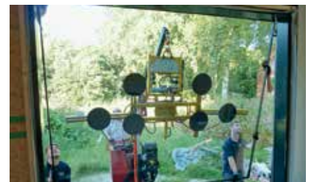
Schritt 5: Mit dem hydraulischen Kranearm setzen Sie die Scheibe millimetergenau in den Rahmen und lösen Sie diese per Knopfdruck.
